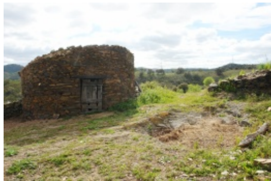
Palheiro e estrumeira pertencentes às “casas velhas” na Alcaria Pedro Guerreiro.
