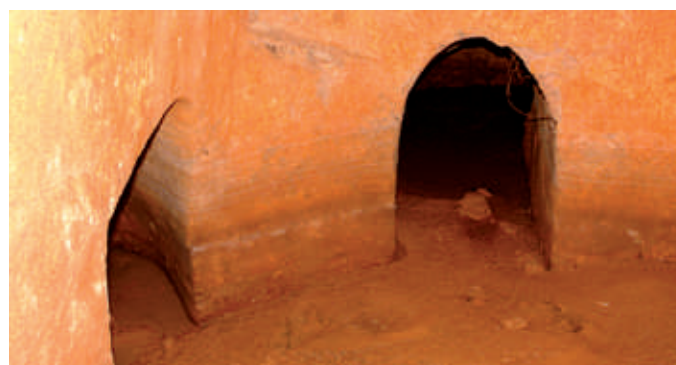
Pormenor da estrutura que suporta a abóbada da sadr al-sāqiya, na mina primária do Barranco da Nora
