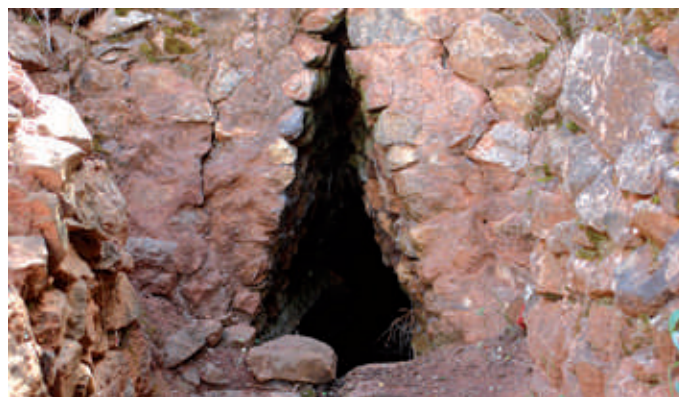
Vista exterior de duas minas de água em Valongo, cuja captação se realizava através do sistema andalusi designado sadr al-sāqiya
