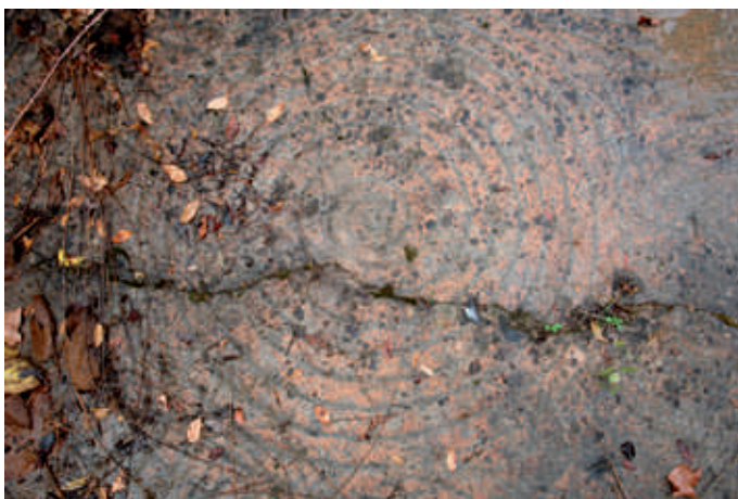
Alverca (tanque) no Barranco da Nora com pavimento de argamassa de cal formando círculos concêntricos
