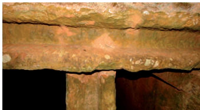
Pormenor da estrutura de suporte da abóbada da sadr al-sāqiya , na mina primária do Barranco da Nora
