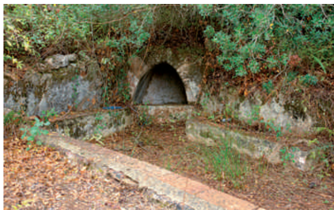
Vista exterior da mina secundária de água do Barranco da Nora, cuja captação se realizava através do sistema andalusi designado sadr al-sāqiya
