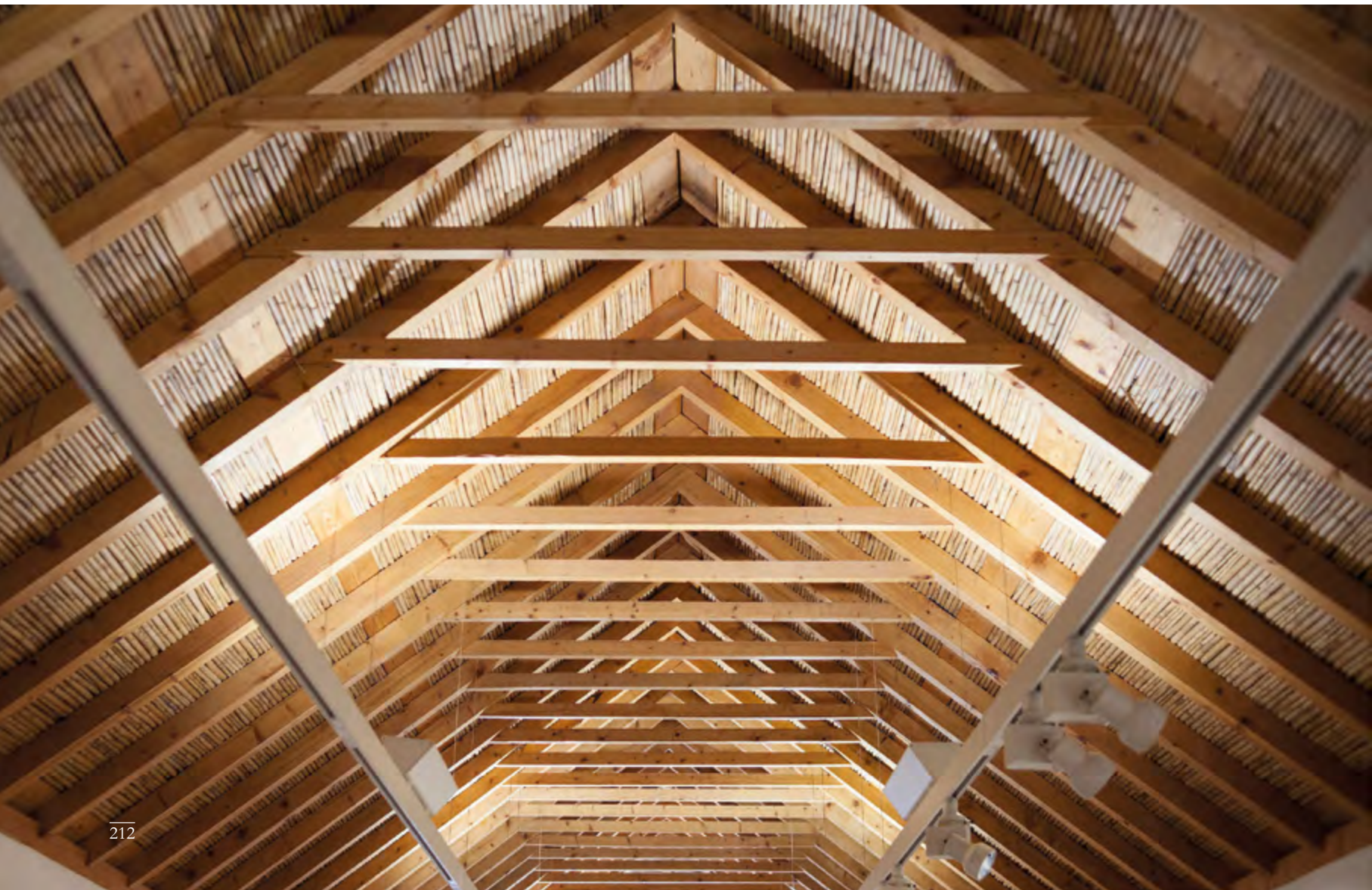
Fig. 05 Estrutura Interior de telhado de tesouro. Palácio da Galeria. Tavira.
